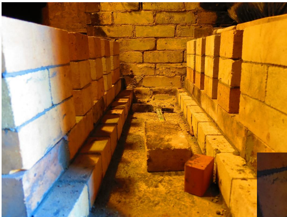
Pilt 15. Keskmine rida ja tuharest paigutatud. Kerise sisemus sai tehtud kausi-kujuline. See nipp hoiab halge koos ning tagab ühtlasema ja täielikuma põlemise.
