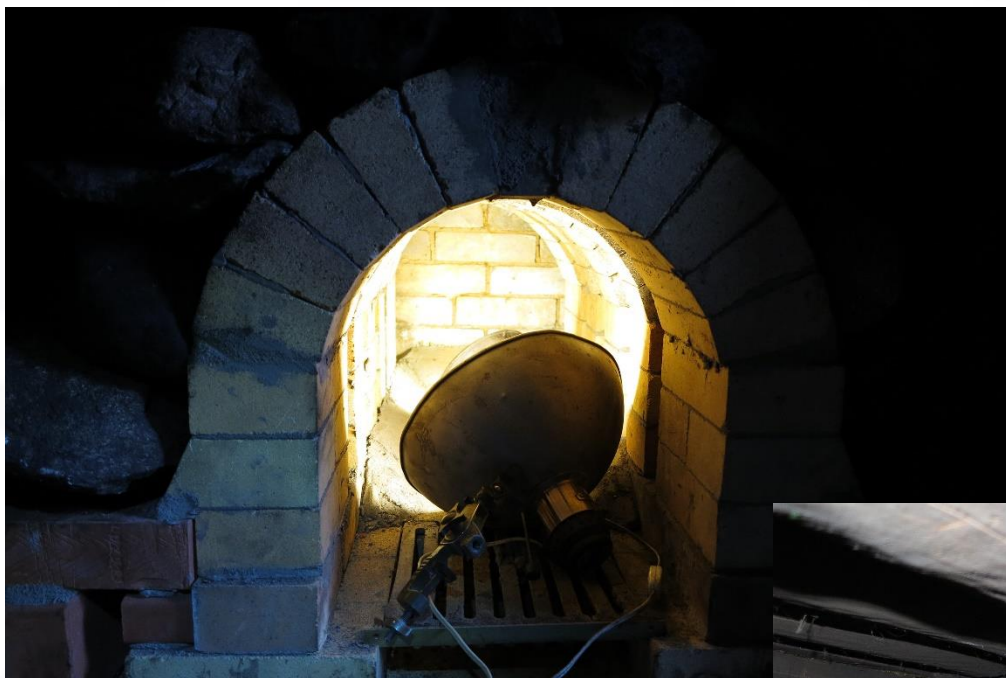
Pilt 32. ... ereda lambiga kerise seest valgust näidates on võimalik väljast märgata suuremaid auke kivide vahel.
