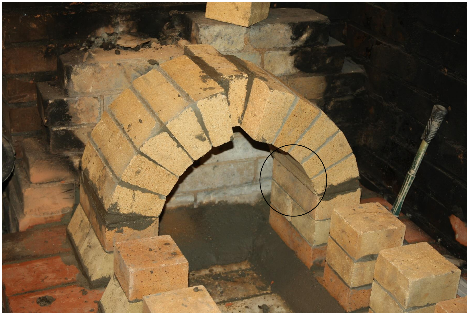
Pilt 20. Jälgida tuleks, et kivide nurkadel oleks otsene kontakt.
