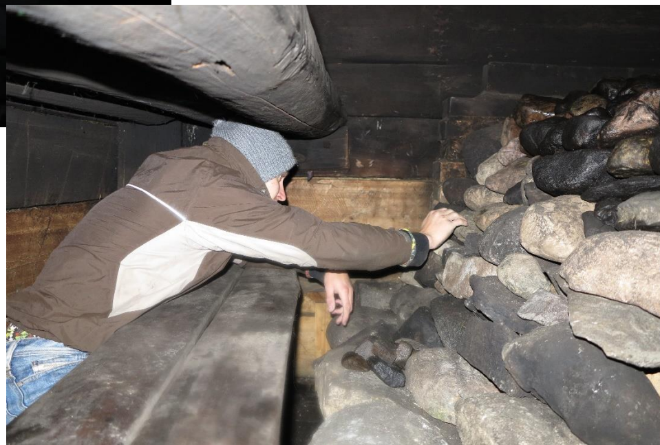
Pilt 33. Õpipoiss pani ka käe külge ning sobitas suurematesse avavustesse väiksemaid kivi kilde, mis takistavad leegil välja vupsamist. Saunakütmise ohutuse seisukohalt on see väga oluline.
